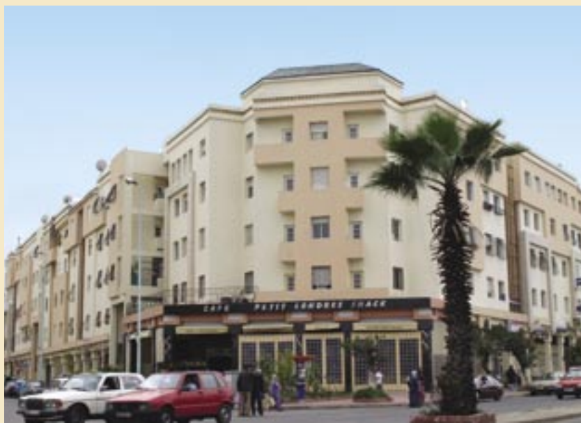
Les lotissements Al Firdaous, que le groupe Addoha a réalisés à El Oulfa, Casablanca.
